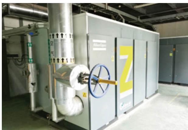
宜兴场地的污水处理项目
