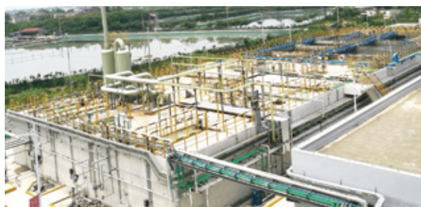
桐乡场地全新的气味控制设施
