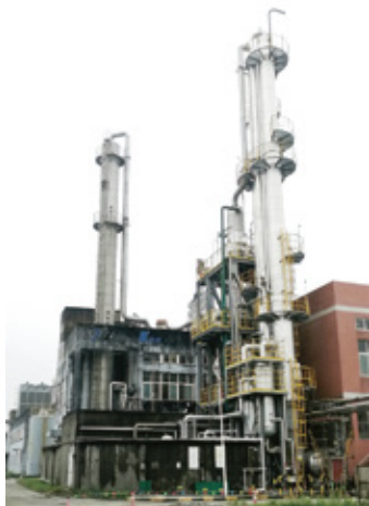
双效酒精蒸馏塔
